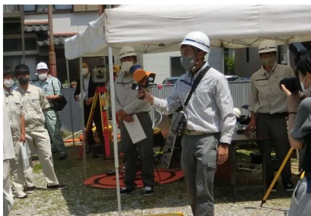
モバイル3Dスキャナの計測状況
