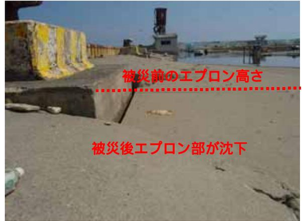
岸壁横のエプロン沈下状況
