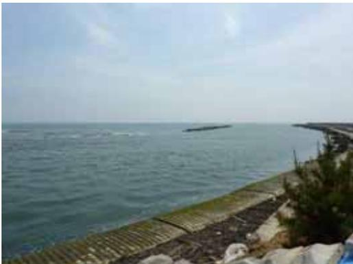
名取川右岸堤防と沈下した左岸導流堤
