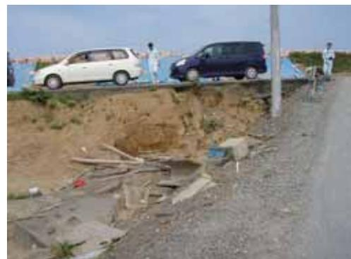
写真 4.越流水による河川堤防法尻部の洗掘
