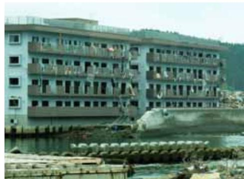
防潮堤の破壊による基礎地盤の流出
