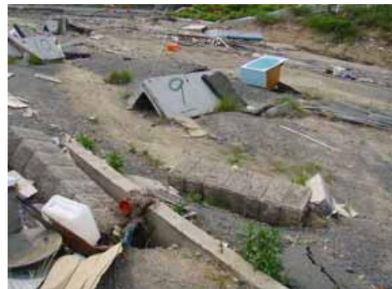
写真 8. 堤内地に散乱する胸壁
