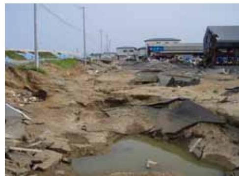
写真 3.越流水による河川堤防天端部の洗掘
