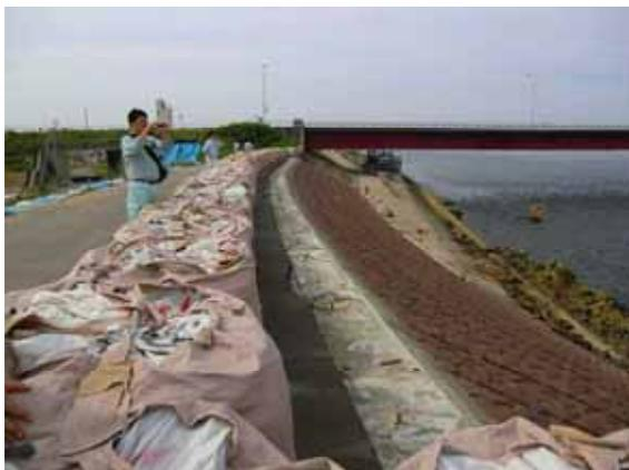
写真 6. 阿武隈川護岸の被災状況
