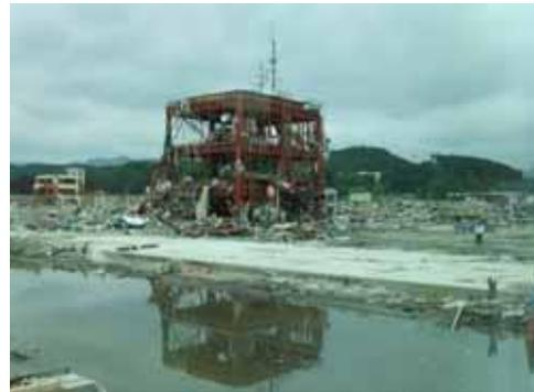
南三陸町防災対策庁舎と地盤沈下による浸水状況
