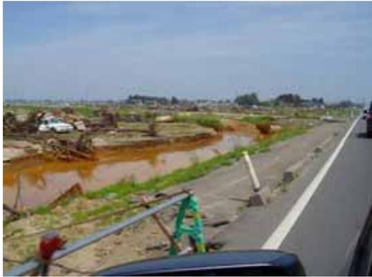
写真 5. 越流水による道路盛土の洗掘
