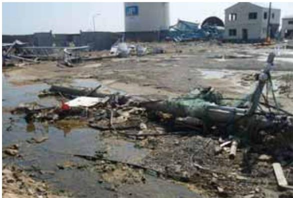
地盤沈下による浸水状況
