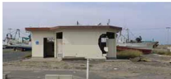
漂流物の衝突により局所的に破壊された公衆トイレ。
