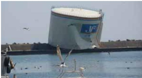
引波によるオイルタンクの被害状況
