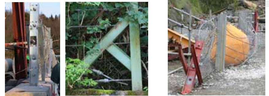
端末支柱のウェブが局部破壊
